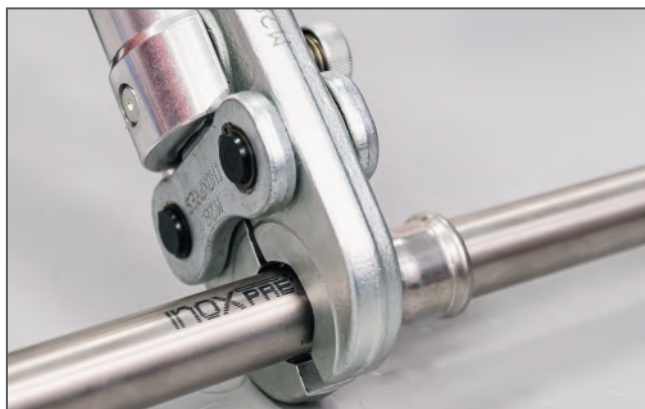
Assemblaggio attraverso pressatura / Making the press connection
